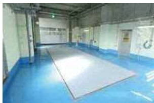
トラックスケール
