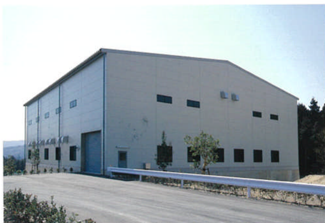
埋立処分施設
