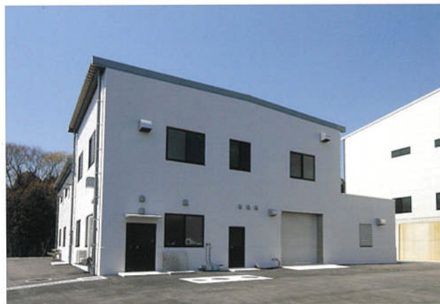
浸出水処理施設
